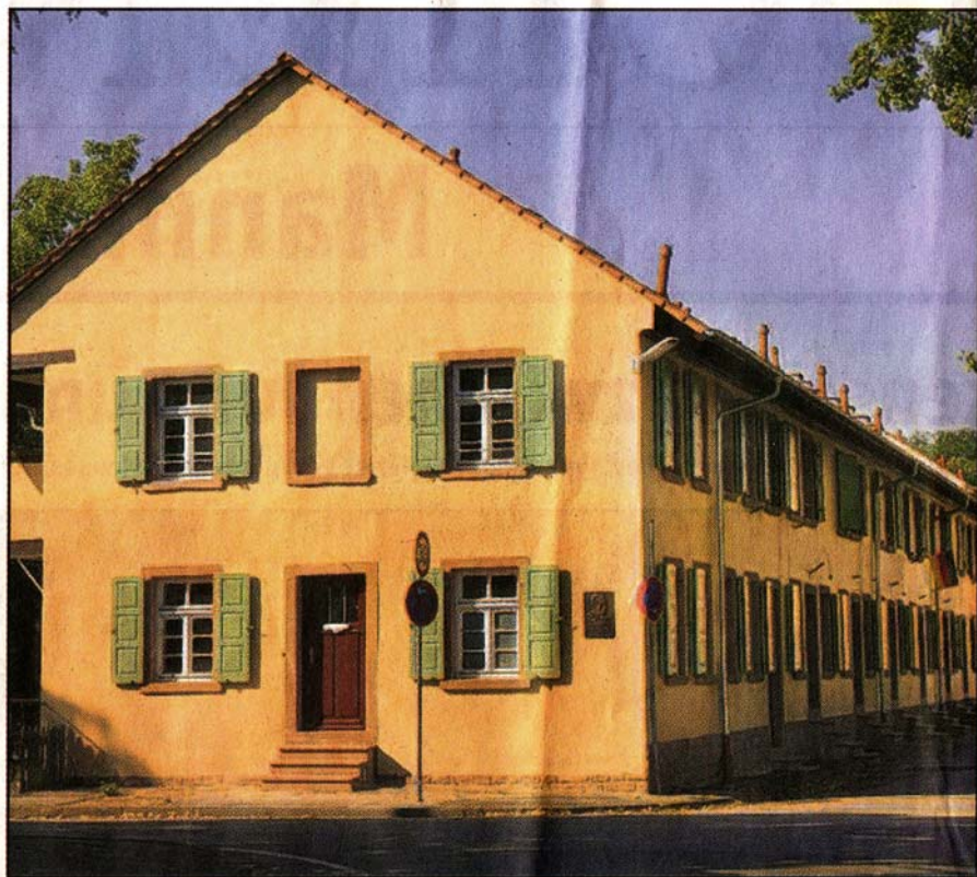
Neues Leben in der alten Arbeitersiedlung. Nach umfangreicher Sanierung erstrahlt die Spiegelsiedlung auf dem Luzenberg wieder in neuem und zeitgemäßem Licht.
