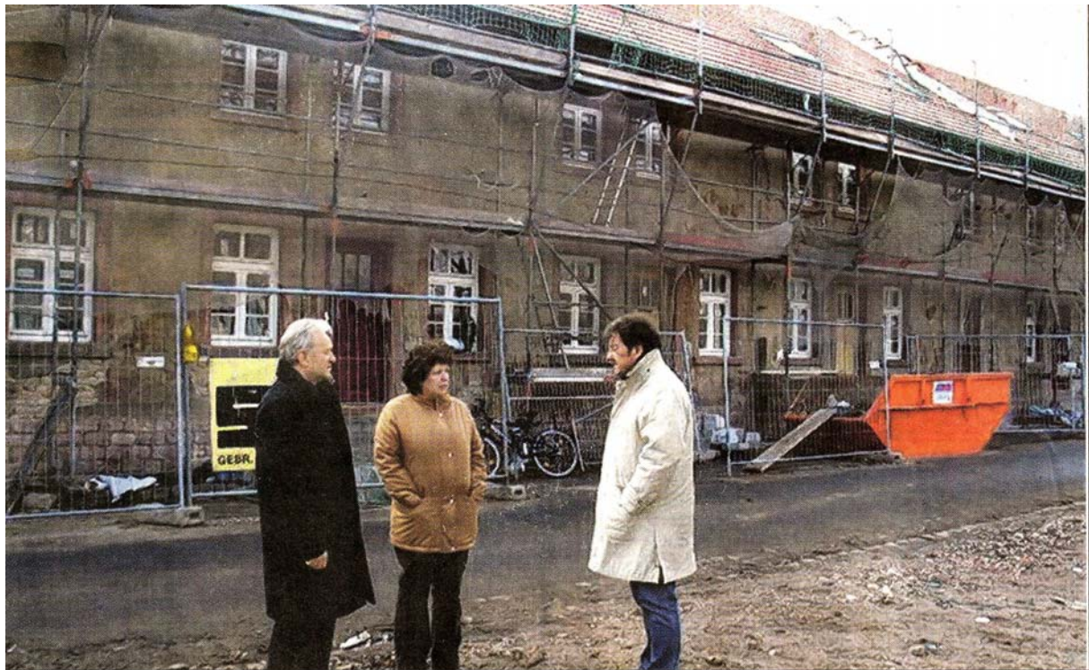
Außen ist noch einiges zu tun bei der Spiegelsiedlung, aber Bauleiter Keim ist bester Hoffnung, dass der Rest der Siedlung im April im neuen Glanze erstrahlt. Lothar Mark und Bezirksbeirätin Gudrun Müller hören es gerne. Bilder: BÜ
